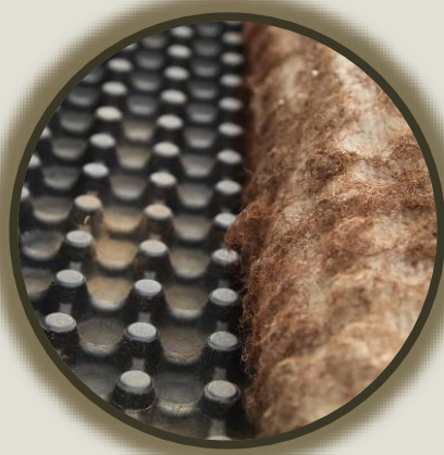
Nopová fólie a geotextilie po třech letech provozu.
